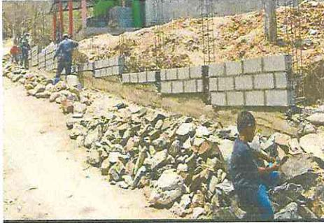
Foto1: Reparación de Muro perimetral
